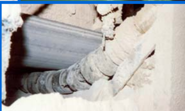
Op van schokdempers voorziene onderbouw.
